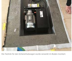
Die Technik für den Scherenhubwagen wurde versenkt im Boden montiert.
