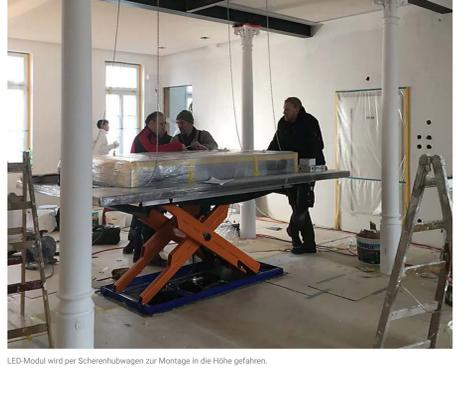
LED-Modul wird per Scherenhubwagen zur Montage in die Höhe gefahren.
